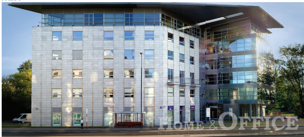
Biurowiec przy ul. Powązkowskiej 15 w Warszawie
