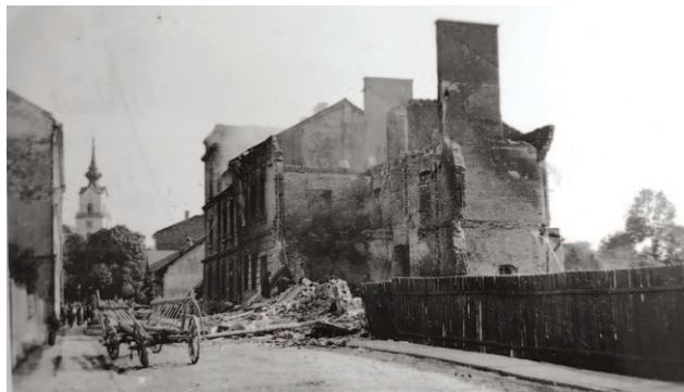
Zniszczona kamienica, w tle widać wieżę Sądu Okręgowego w Rzeszowie
